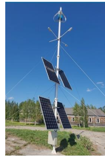
Энергоустановка ВИА: солнечные панели и ветрогенератор
