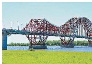
Автомобильный мост через Иртыш «Красный дракон» в Ханты-Мансийском автономном округе. Открыт в сентябре 2004 г.
